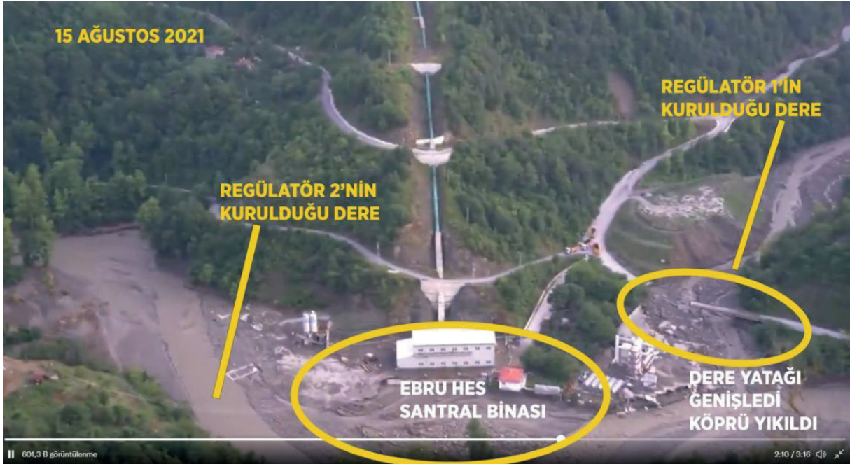
Görsel 7: Ebru HES projesinin regülatör ve santral binası ünitelerinin kurulduğu alanın 15.08.2021 tarihli görüntüsü
